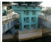
特殊橋梁補強
