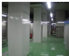
地下中柱補強
