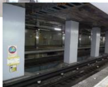
落橋防止対策・柱補強 (2021年度完了予定)
