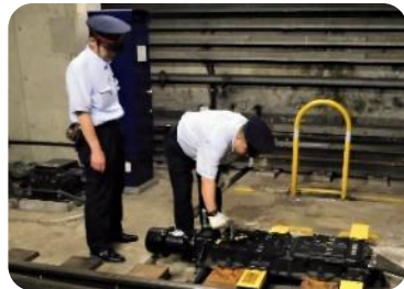
信号保安装置故障時の対応訓練
